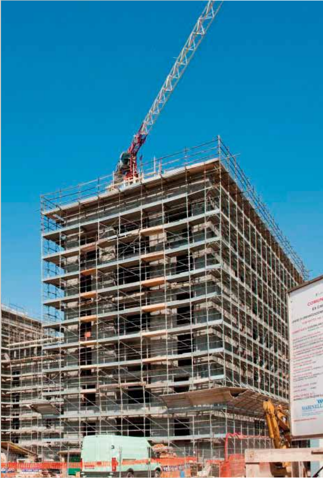
Vista frontale edificio A
