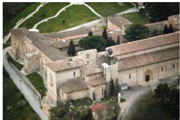
Conservatorio "Alfredo Casella" (accanto alla Basilica di Collemaggio)
