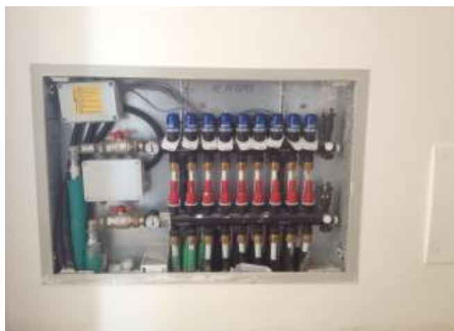
Immagine impianto a pannelli radianti a pavimento e collettore di ispezione impianto.
